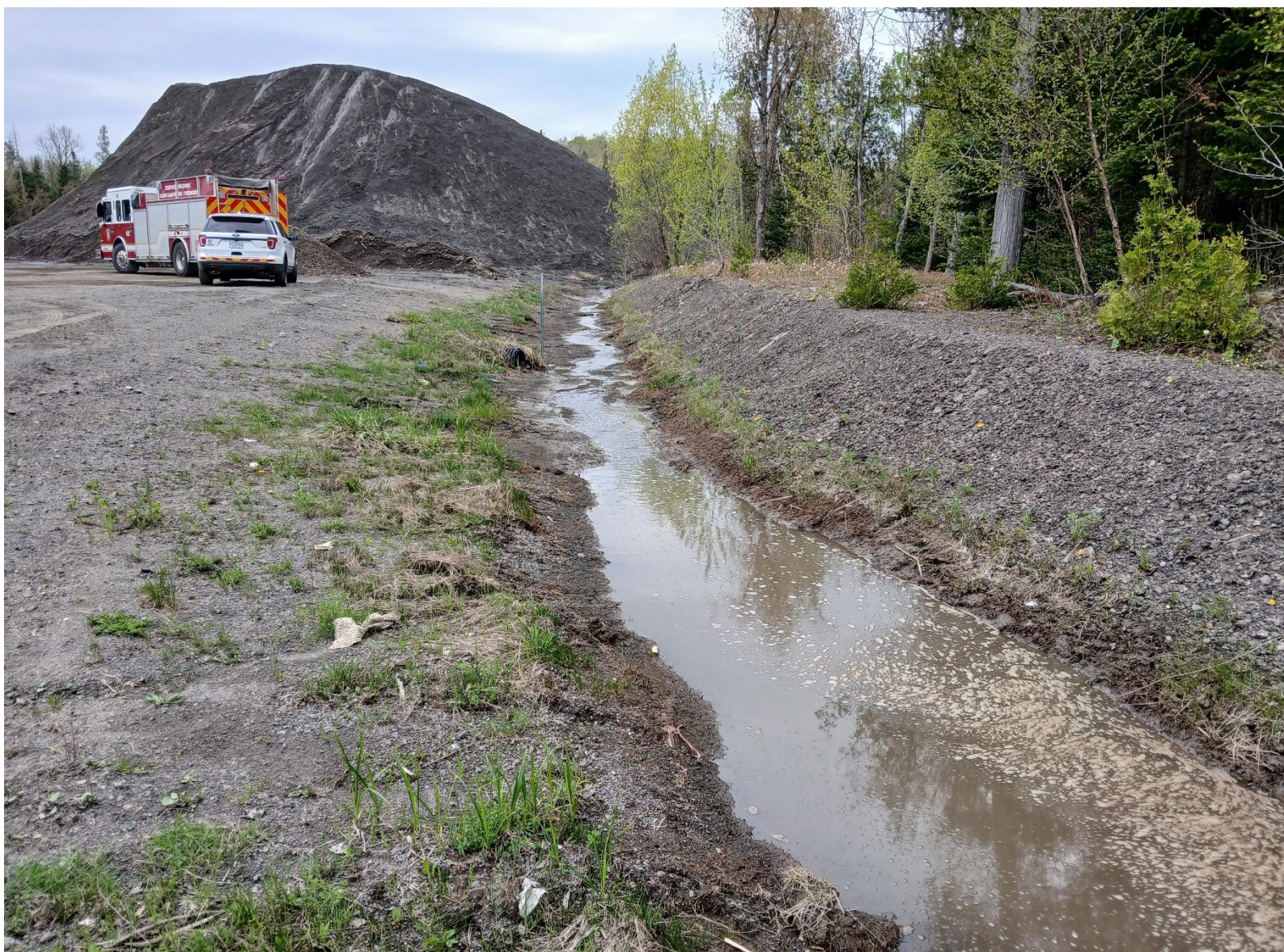
C) Lit d'écoulement résultant du ruissellement de l'eau de fonte année après année. Notons la turbidité et le film à la surface de l'eau, de même que le sol à nu dans le 10 mètres de tampon devant servir de bandes riveraines végétalisées. Crédit photo : Eric Guerra-Grenier.
