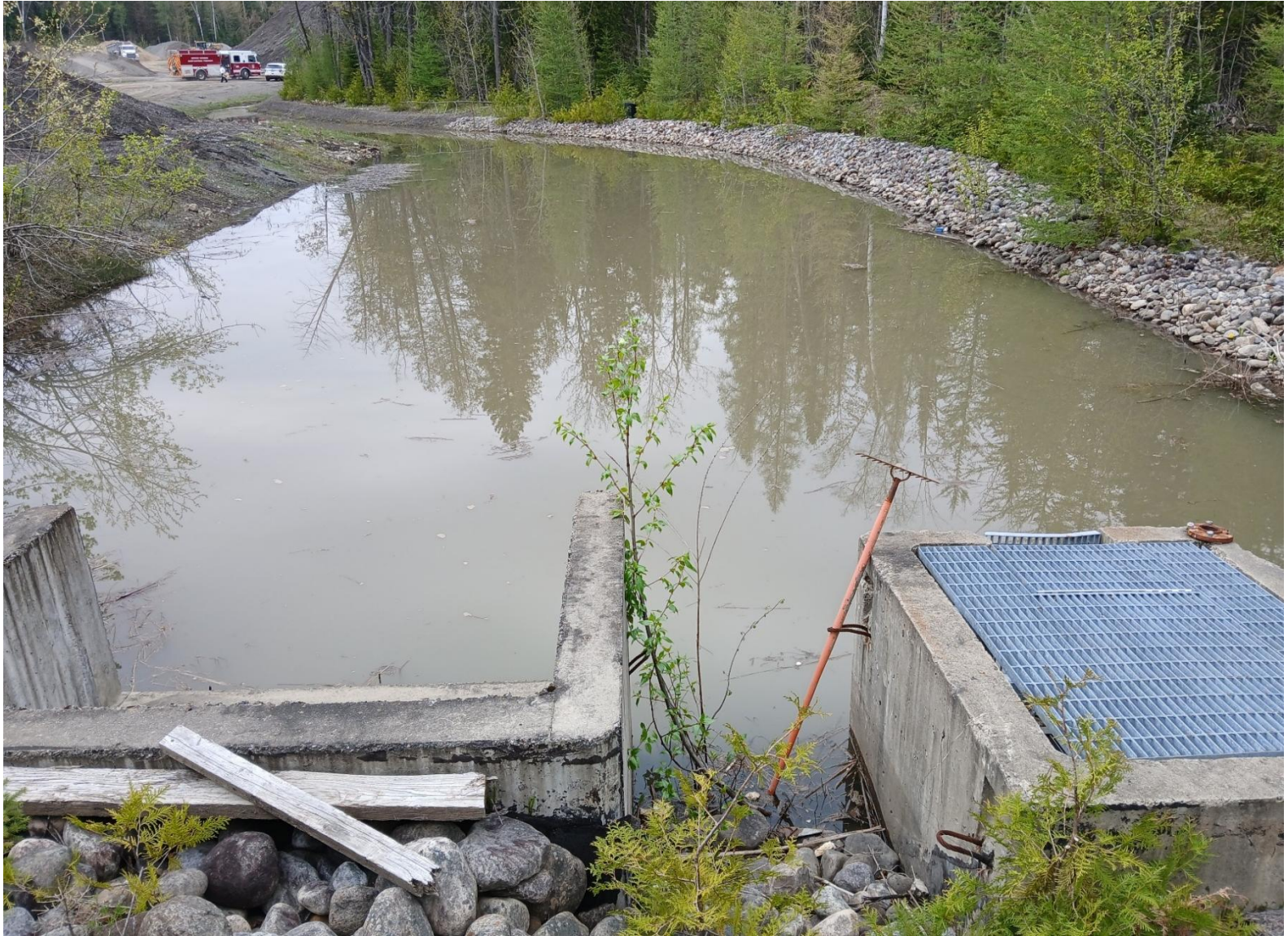
D) Bassin de sédimentation à l'aval du lieu d'élimination de neige. Cet aménagement permet la sédimentation des matières en suspension, mais ne peut bloquer la circulation d'autres contaminants tels les chlorures. Crédit photo : Eric Guerra-Grenier.
